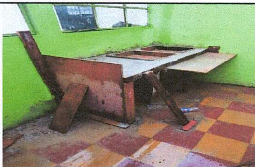
Foto 5: Proceso de construccion de lavatrastos.
