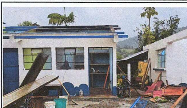
Foto 2: Sustrución de láminas para area de cocina y baños de 9.5*5 mts equivalente a 47.5mts2
