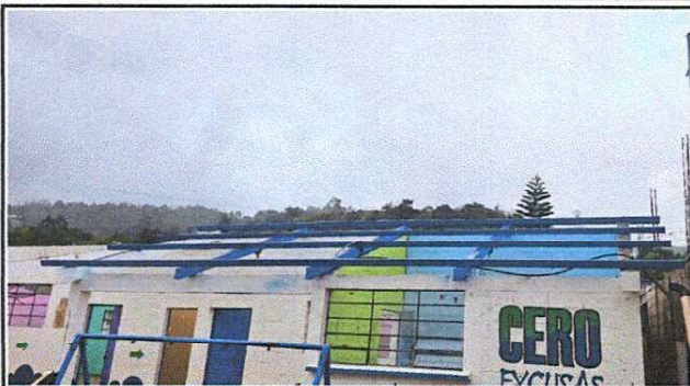
Foto 1: Sustrución de cubierta de lámina en 2 aulas con un área de 10.5*22 mts equivalente a 231 mts2
