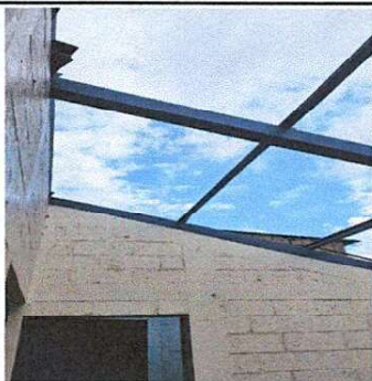
Foto 3: Sustrución de estructura de techo área de aula 2
