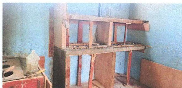
Foto 6: Proceso de cambio de gabinete a de concreto, contruccion
